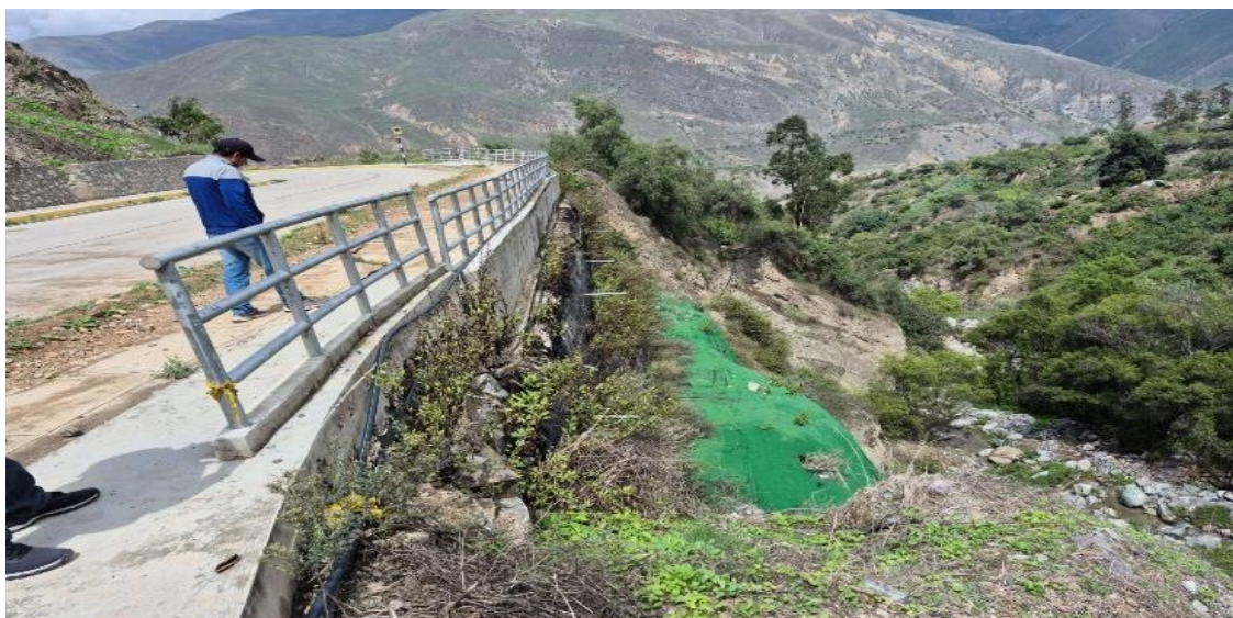
FOTOGRAFIA N°02: TRAMO CRÍTICO EN LA QUEBRADA UPRGA, ENCONTRÁNDOSE SOCAVADO LA DEFENSA Y EXPUESTO A PELIGRO RED DE AGUA Y DESAGUE.
